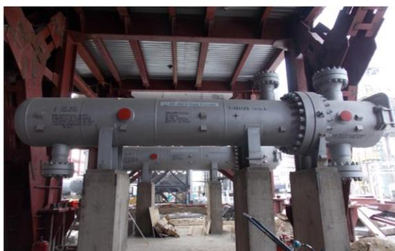
**Теплообменники Т-102 и Т -101 циркуляционного водородсодержащего газа производства дизельного топлива на АО «АНХК»:  $P = 10, 25 \text{ МПа}$ ,  $t = 455^\circ\text{C}$**
