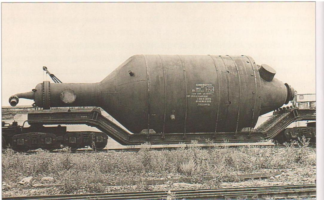
**Конвертор метана агрегата аммиака**
