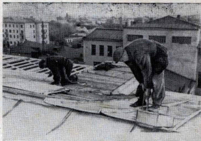
Ведутся большие работы по расширению и реконструкции МХТИ. Уже в этом году должно быть сдано в эксплуатацию правое крыло главного здания с площадью около 2500 кв. м. На снимке: кровельщики за работой.
