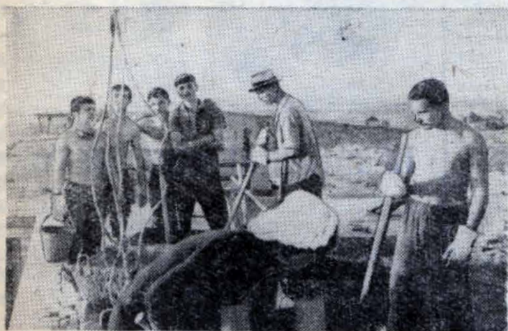
Студенты топливного и неорганического факультетов на крыше будущей школы совхоза «Ермаковский» Павлодарской области.
