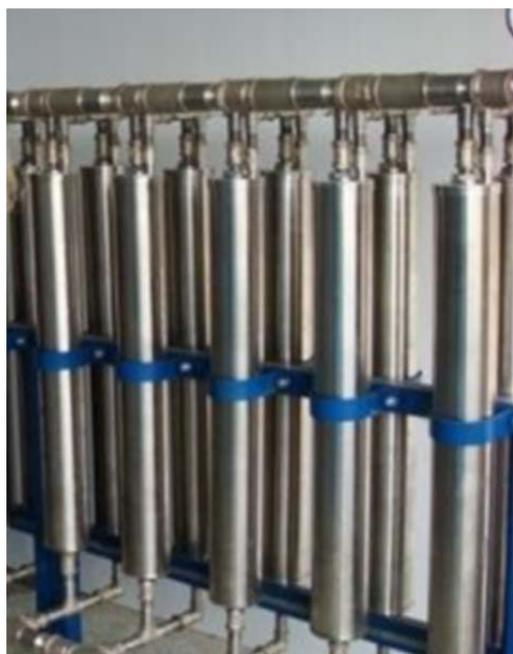
Рис. 3. Фильтры на станции водоподготовки
