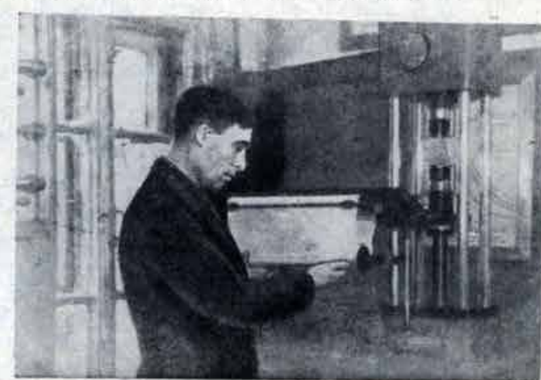
В лаборатории кафедры сопротивления материалов. Преподаватель Н. Воробьев за работой на универсальном прессе по испытанию материалов на прочность. Фото Н. Иванова.
