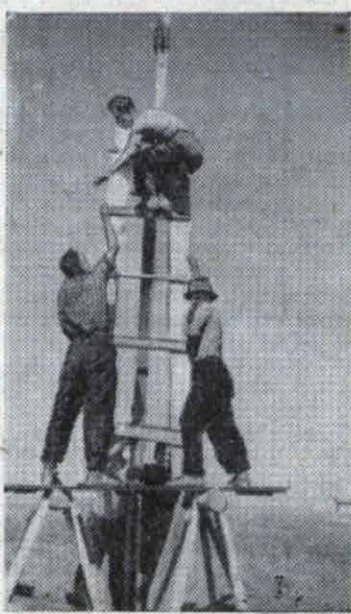
Студенты на монтаже электролинии.
