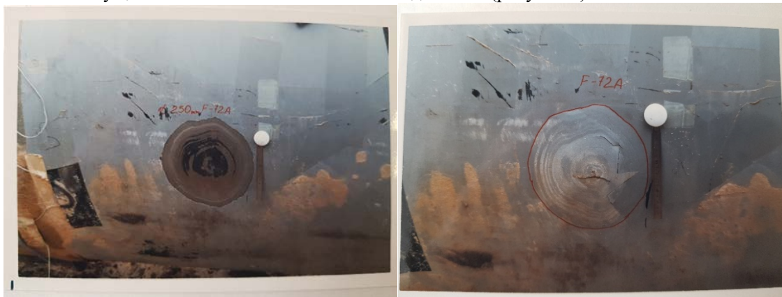
Рис. 1. Дефекты, выявленные при обследовании трубопроводов Fig.1. Defects identified during pipeline inspection
