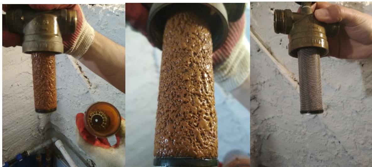
Рис. 1 - «Забитый железом» сетчатый картридж магистрального фильтра (А и Б) в сравнении с фильтром очищенным (В)
